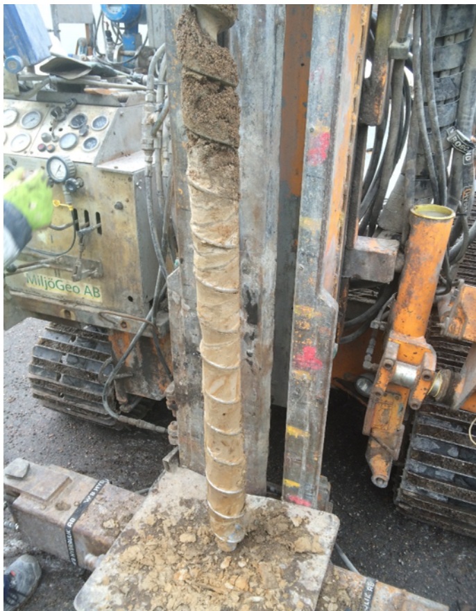
Figur 3: Renskrapad jordskruv, redo för uttag av jordprov
