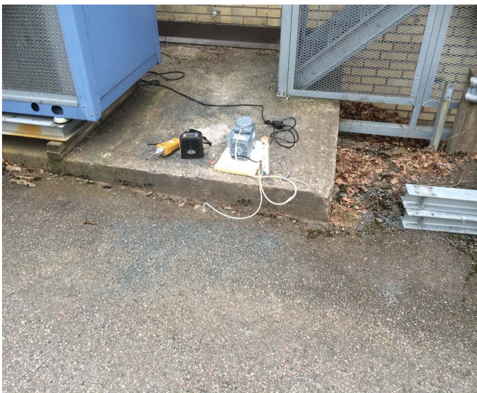
Figur 5: Porgasprovtagning under asfalt vid bottenplattan för den f.d. tri-tanken (GAS04)
