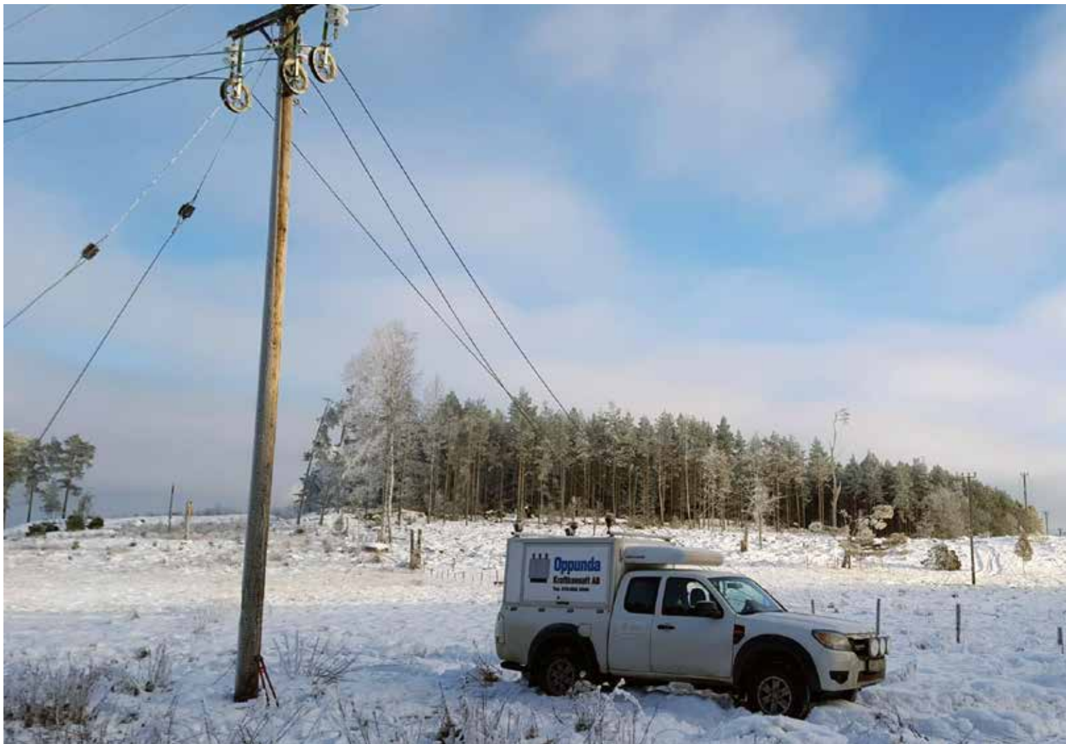
Oppunda Kraftkonsult utför och underhåller infrastruktur på alla spänningsnivåer mellan 0,4 - 52 kV samt optoförläggning.
