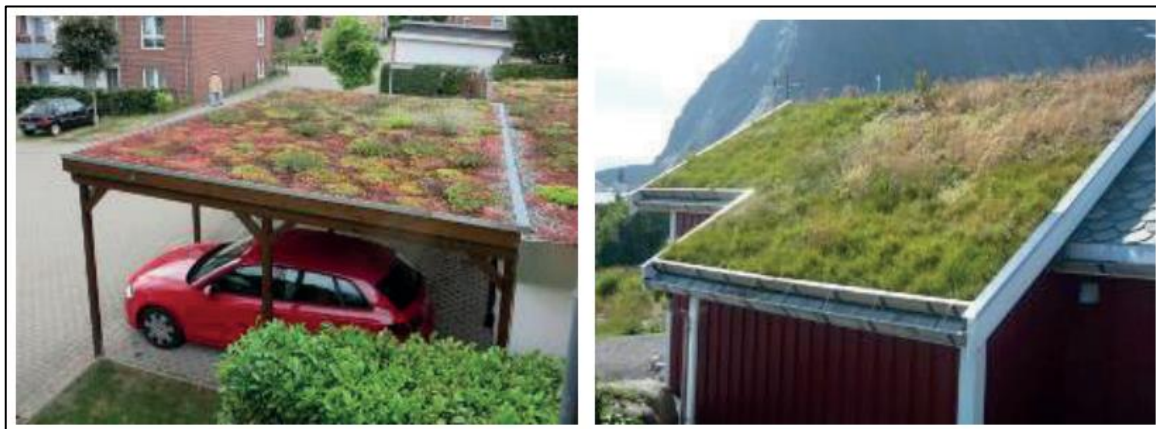
Figur 13: Exempel på sedumtak (Blecken, 2016).
